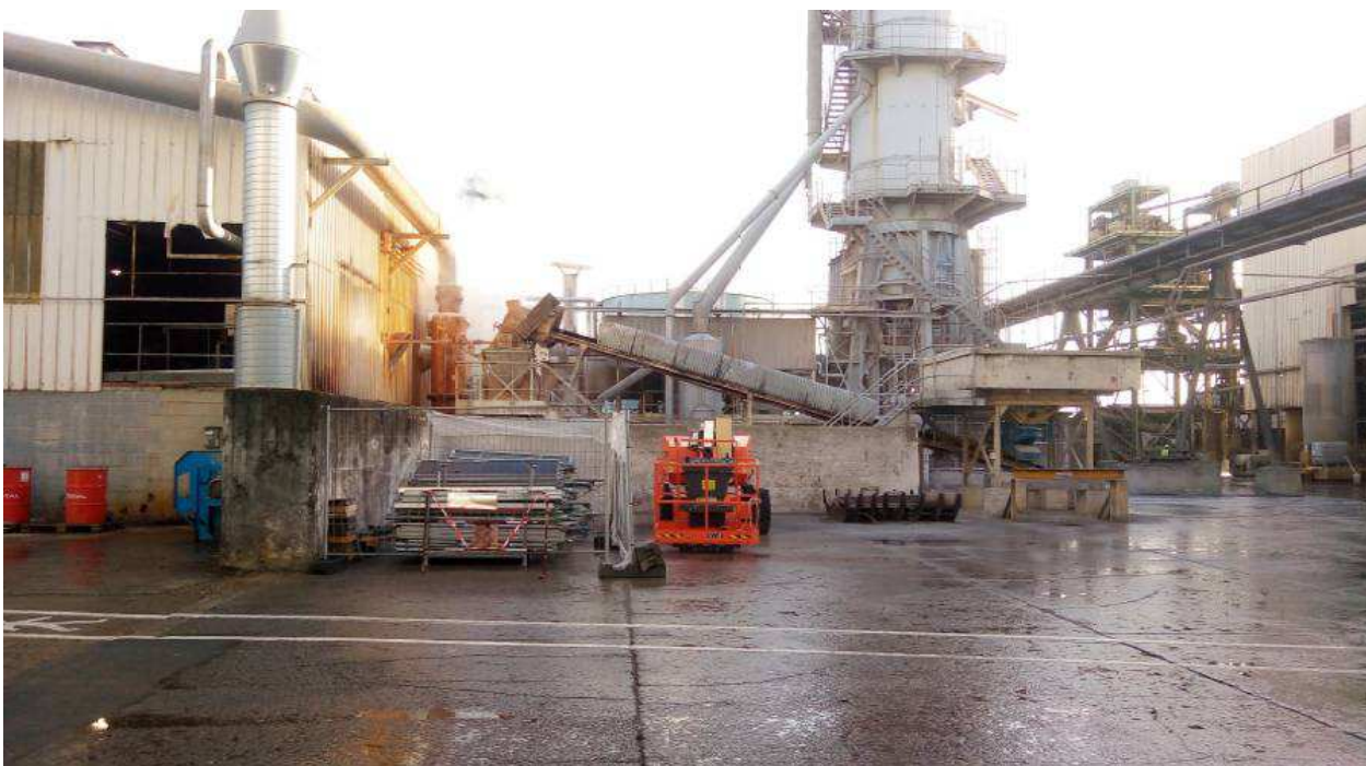
VUE DE LA ZONE D'IMPLANTATION DU MAGASIN DE STOCKAGE DE SOUFRE
