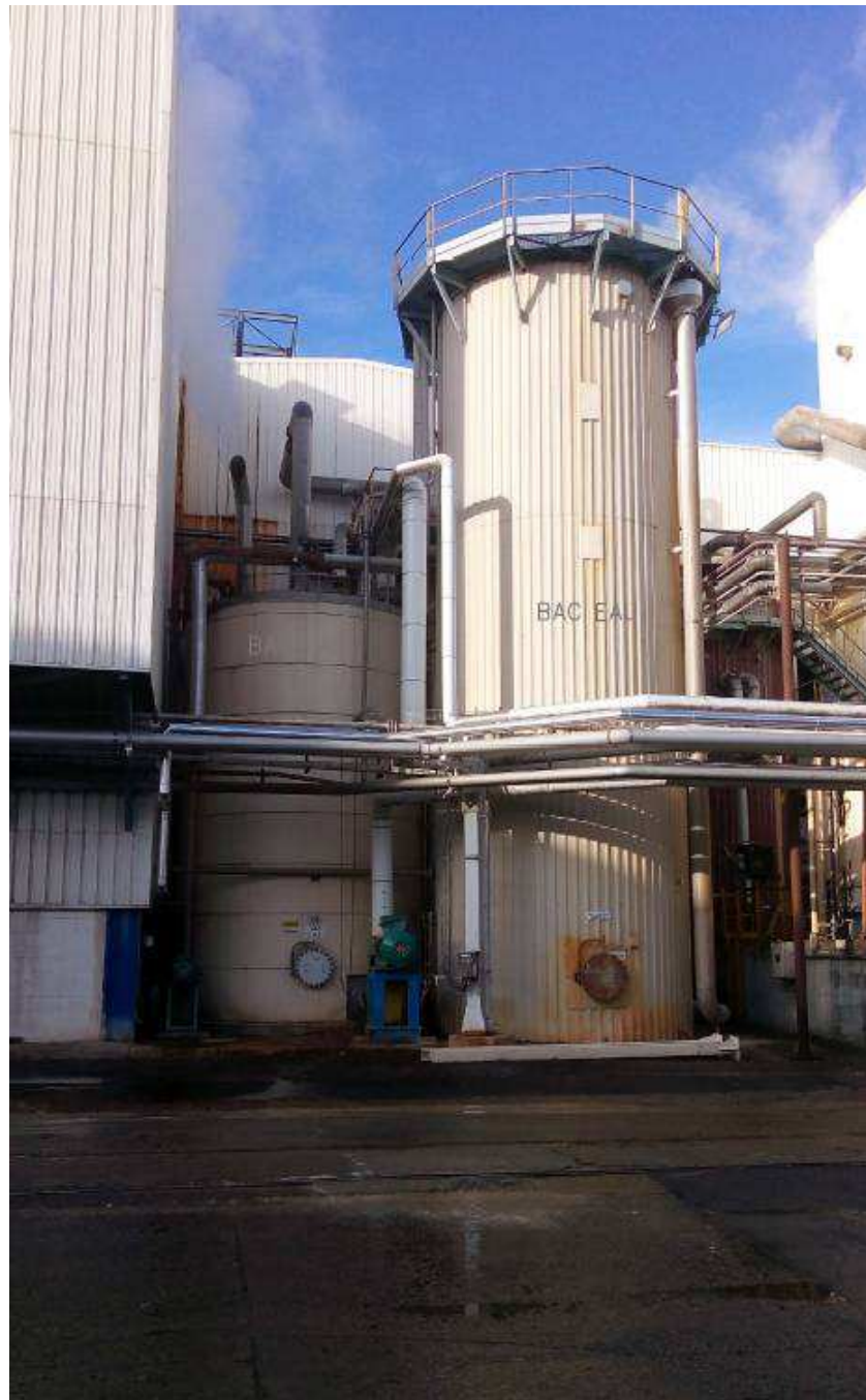
VUE DE LA ZONE D'IMPLANTATION DU FOUR A SOUFRE
